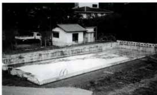
改築される淮國小プール
