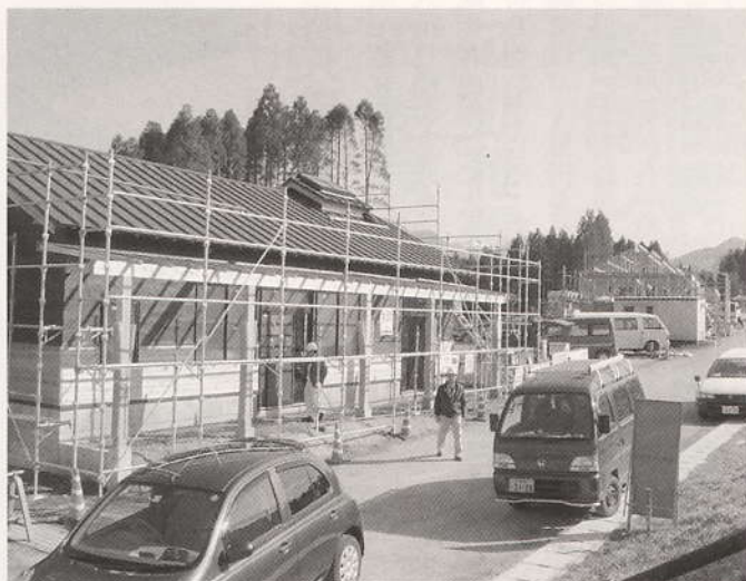
吊り橋駐車場付近に建設中の管理棟
