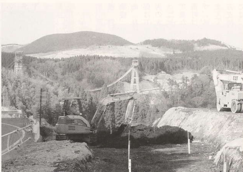
吊り橋に通じる県道バイパス
