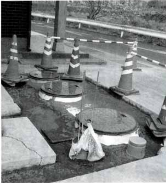
次々に設置される浄化槽
