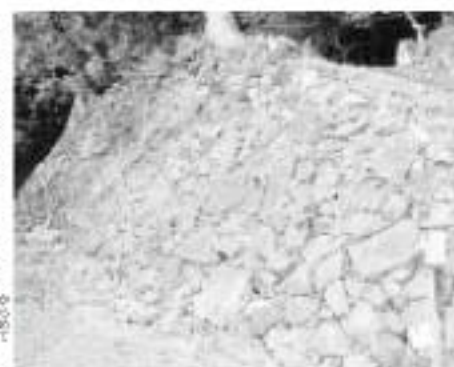
角牟礼城の穴太積み石垣(伝馬手門)。*前手とは、城の裏門。大手門の礎
