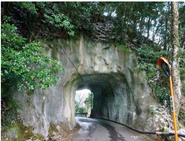
終点側坑口部
