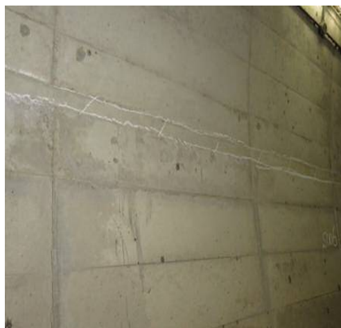
S06 の水平打継目沿いのうき
