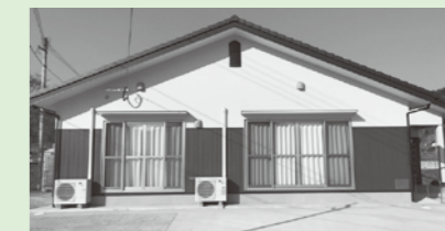
田尻集会所（令和元年度完成）
