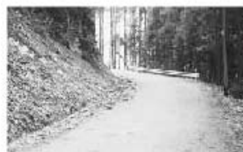
改良が期待される道路
