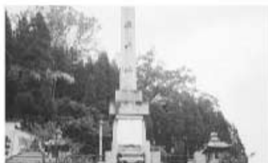
老朽化で新設が望まれる
