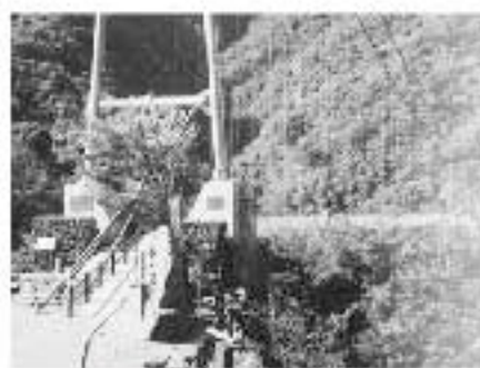
綾町の照業大吊橋
