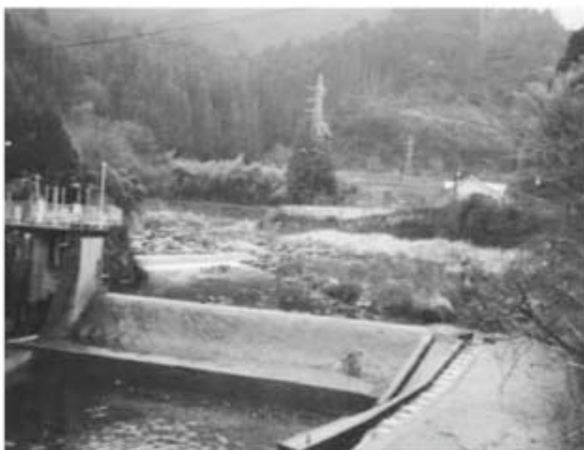
大半が取水される野上発電所の取水口
