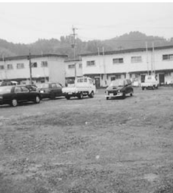
木造3階建てで建設される恵良住宅建設予定地
