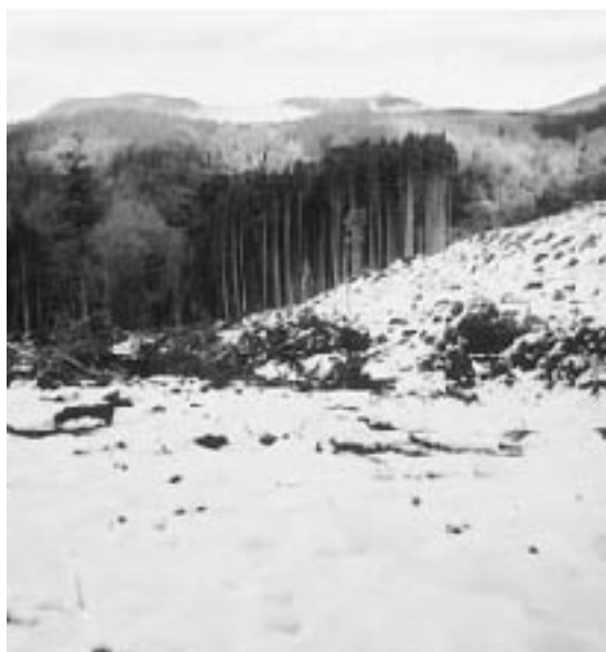
鳴子川溪谷事業中村エリア駐車場の造成工事
