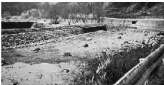
上流に大吊り橋が建設される鳴子川
