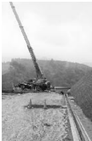
吊り橋工事が進む北方エリア
