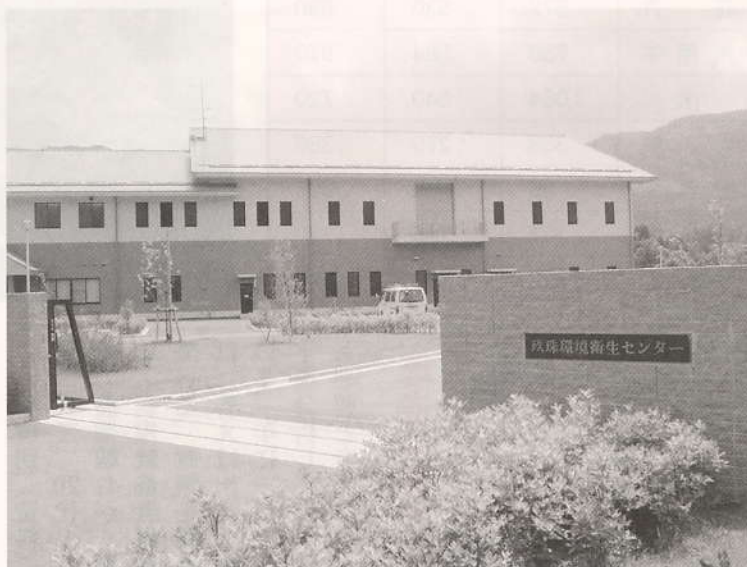
汚泥処理施設の玖珠環境衛生センター
