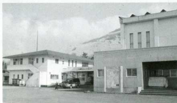
改修される泉水コミュニティセンター・体育館
