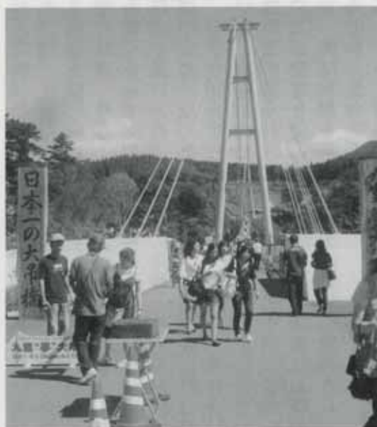
九重「夢」大吊橋
