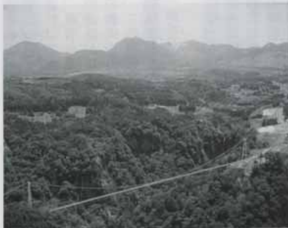
第2次周辺整備が計画されている大吊橋
