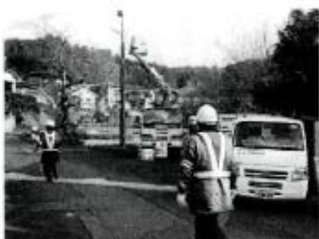
光通信敷設中
