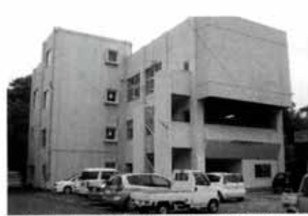
エレベーターの設置が望まれる東飯田地区公民館
