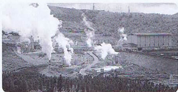
▶日本一の発電量を誇る八丁原地熱発電所
