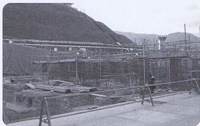
▲建設が進む統合中学校
