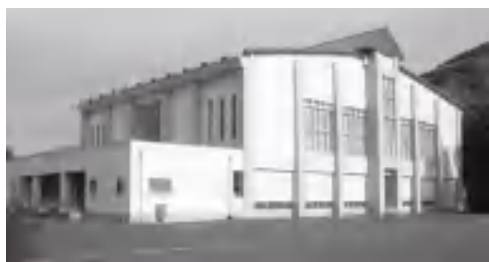
屋根の改修が行われるコミュニティセンター
