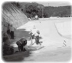
川西木納水支線
