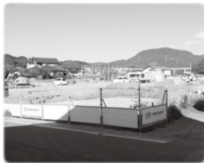
建設が進む北代住宅
