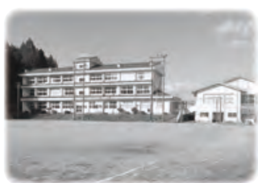
跡地に飯田こども園が建設される旧飯田中
