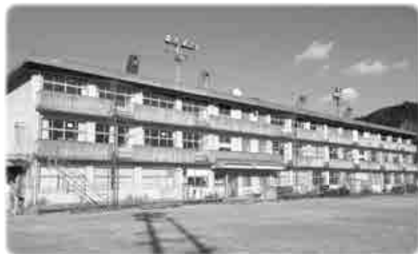
解体予定の旧南山田中学校
