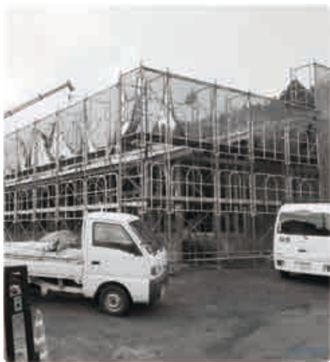
建設が進む飯田こども園(仮称)工事
