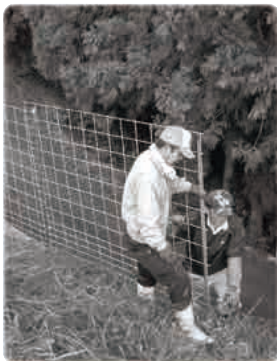
獣害防止柵設置風景
