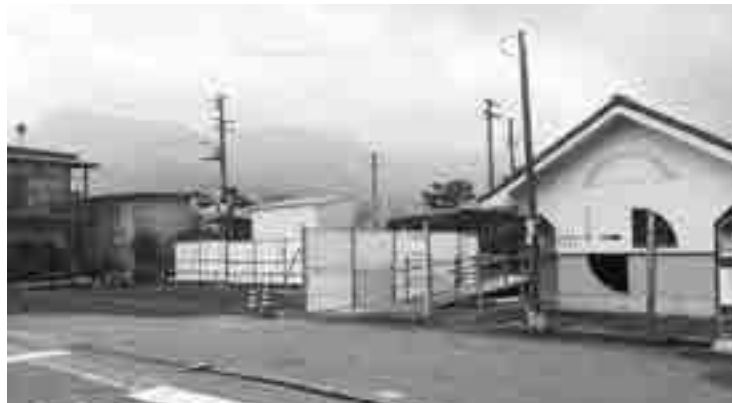
駅舎の建設が始まった恵良駅
