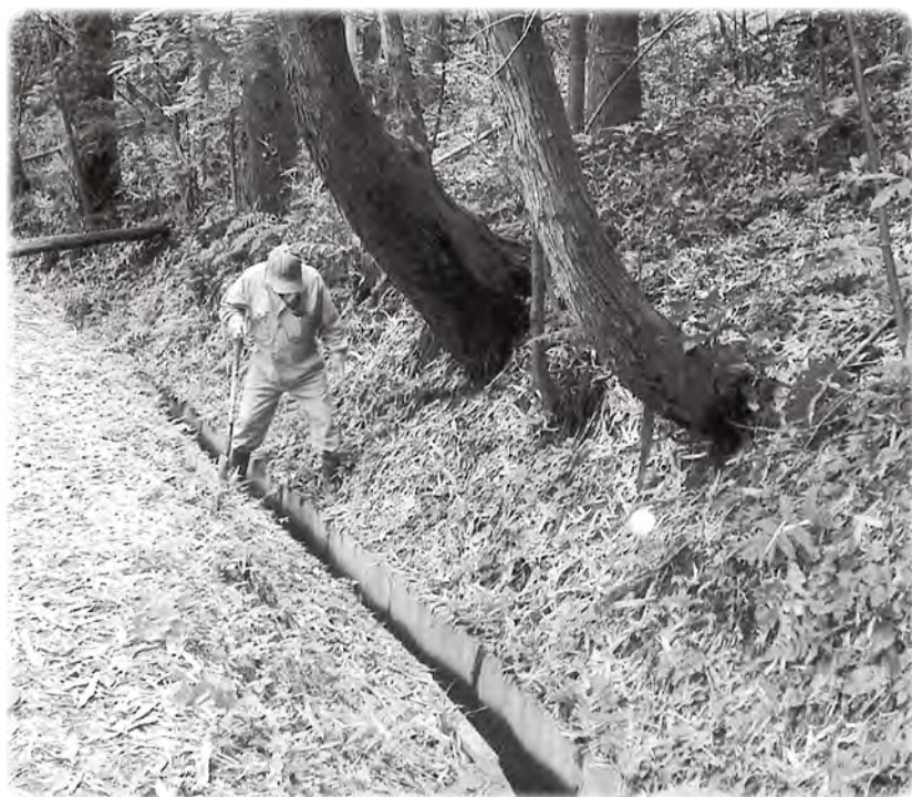
綱掛け井路の水漏れ点検管理
