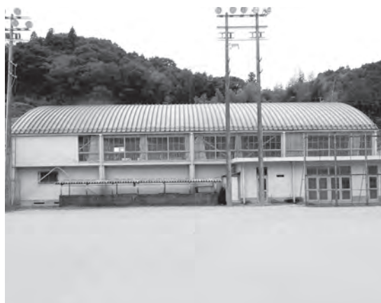
旧南山田中学校体育館
