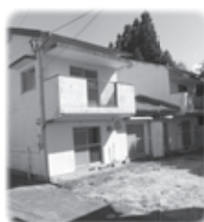
取り壊される予定の住宅
