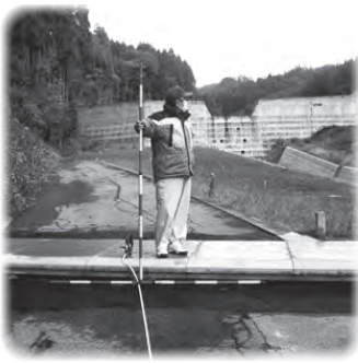
田尻中須線付替完成(上流砂防ダム)
