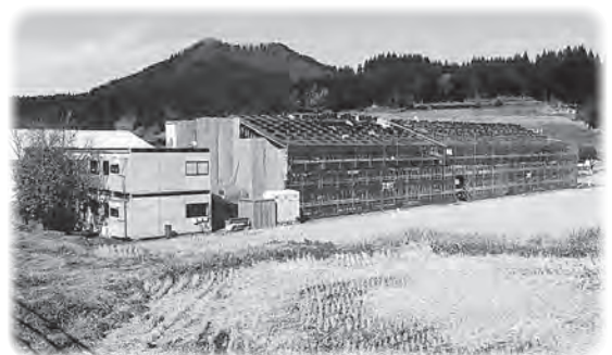
建設中の奥野住宅
