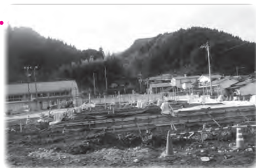
建築中の南山田公民館
