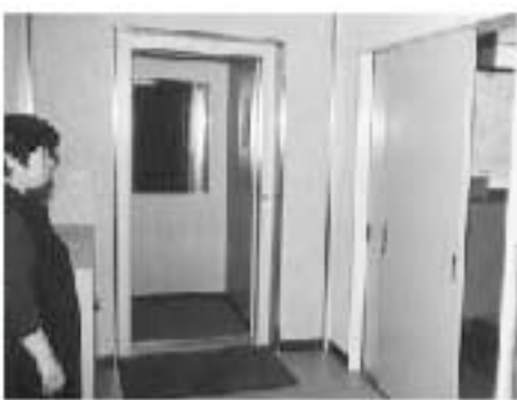
障害のある人にも使いやすく改修した隣保館（エレベーターを取りつけ、ドアを引き戸に）
