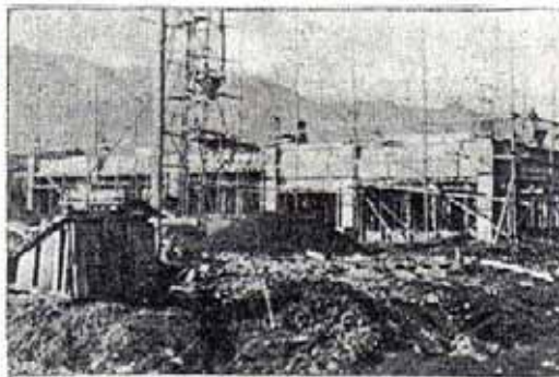
建設中の里立文化会館
