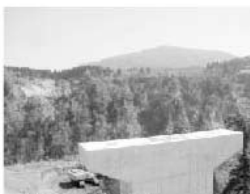
▲現在の鳴子川大吊橋工事現場
