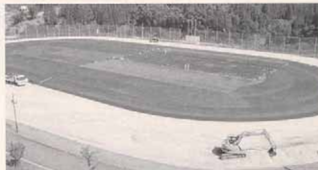
▲工事中の多目的ひろば。芝の緑が鮮やかです。
