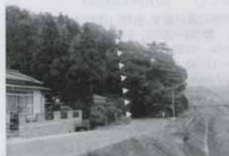
旧トンネル（▶の右側が切り取られた）
