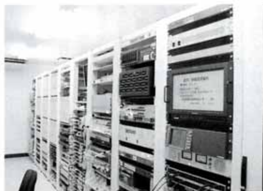
九重ケーブルテレビセンター施設
