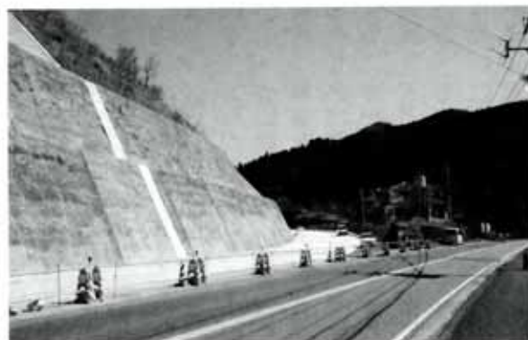
工事中の国道386号線（宝泉寺側）
