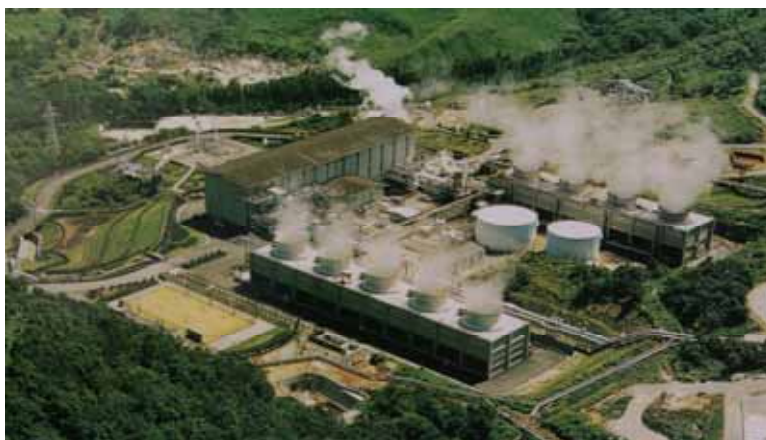
八丁原発電所
