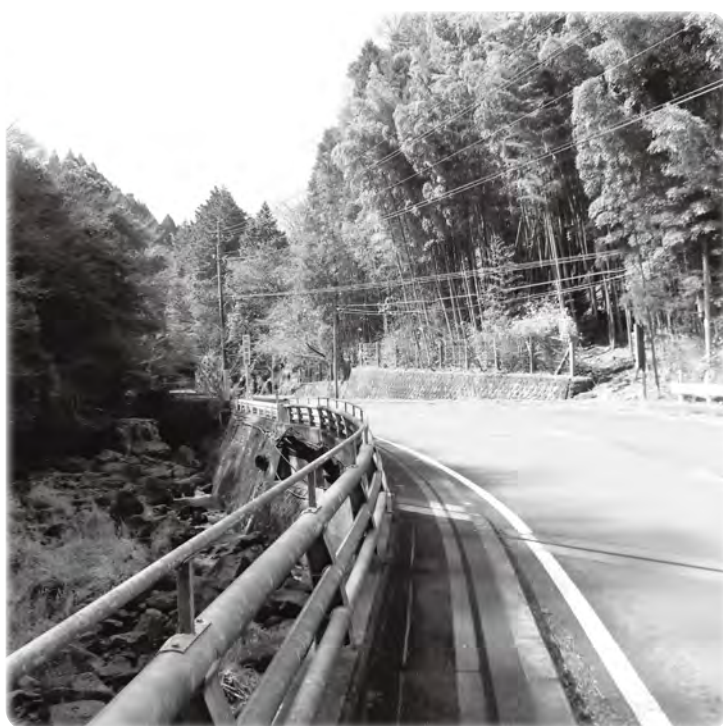
トンネル工事が予定されている国道387号川底付近
