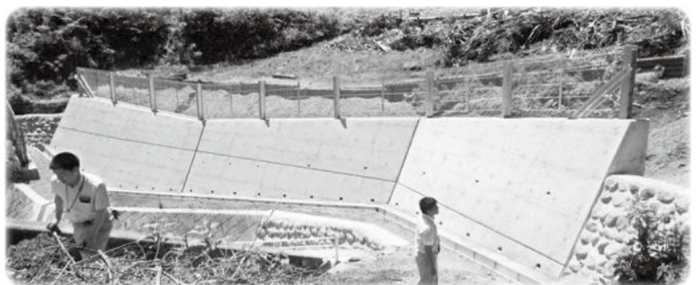
整備された危険箇所
