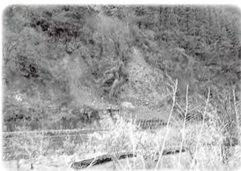
ガケくずれをした県道
