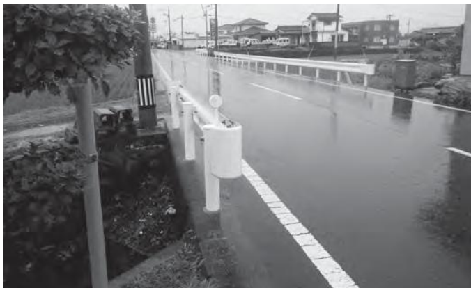
工事申請で整備されたガードレール
