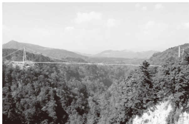
▲九重「夢」大吊橋
