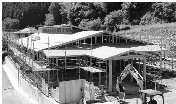
平成30年8月完成にむけ工事中の 野上ふれあい交流センター
