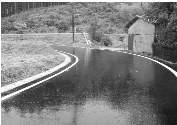
道路改良工事が完了した町道無田硫黄山線
