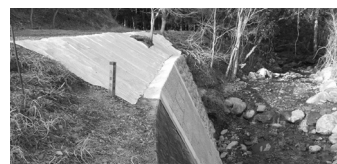
平家川河川災害復旧工事
