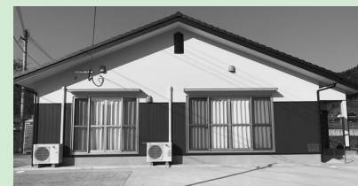
田尻集会所（令和元年度完成）
