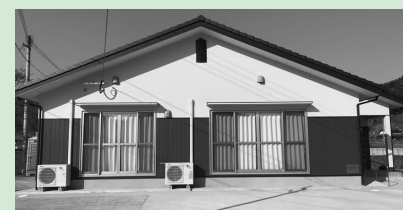
田尻集会所（令和元年度完成）
