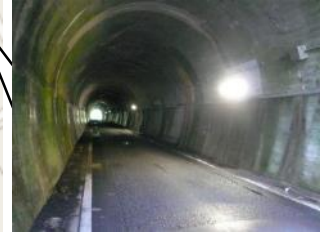
⑤町道 旧引治トンネル内
