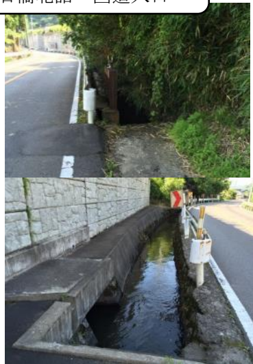
⑧町道（富迫～壁湯線） 潜石橋北詰～国道入口
