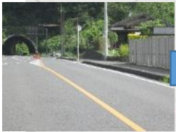
⑤新引治交差点 曲がり箇所にも通行 者用のガードレール なし
