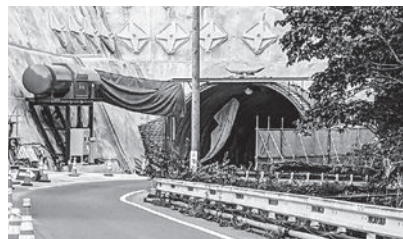
工事中のトンネル
